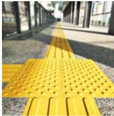
Imagen N° 1: Pavimento táctiles. Fuente: Soluciones de Accesibilidad.
