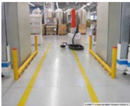
Imagen N° 3: Pasillos con barrera simple reforzada. Fuente: https://www.logismarket.es/
