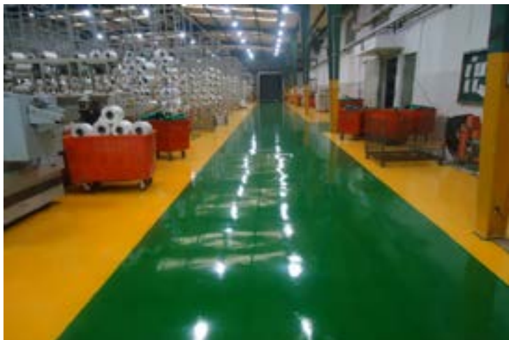
Imagen N° 5: Piso epóxico antiestático. Fuente: http://www.apexsindustrial.com
