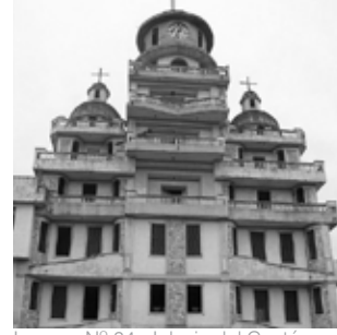
Imagen N° 34.- Iglesia del Cantón Grafica tomada de: http://www.flickr.com/photos/pataaisuelo/3208028761/
