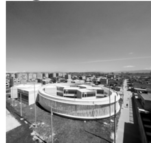
Imagen N° 75.- Case análogo 1: Guardería El Porvenir Tomada de: http://www.architectural-review.com/buildings/el-porvenir-kindergarten-by-giancarlo-mazzanti-bogota-colombia/8603039_article
