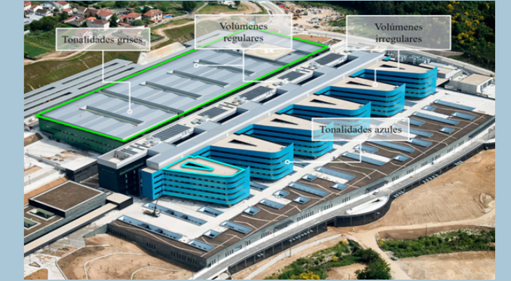
Identificación de Volumetría Hospital Álvaro Cunqueiro Vigo. Servizo Galego de Saúde
