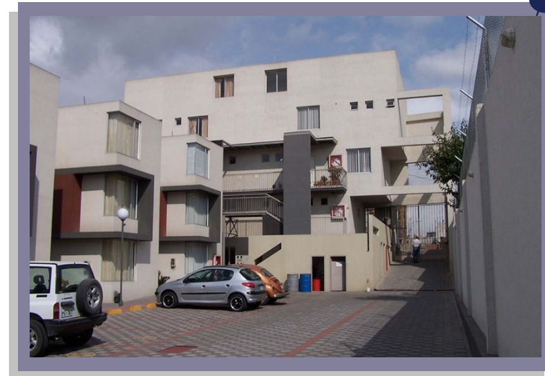
Imagen 30 Fotografía del proyecto vivienda social en Carapungo.
