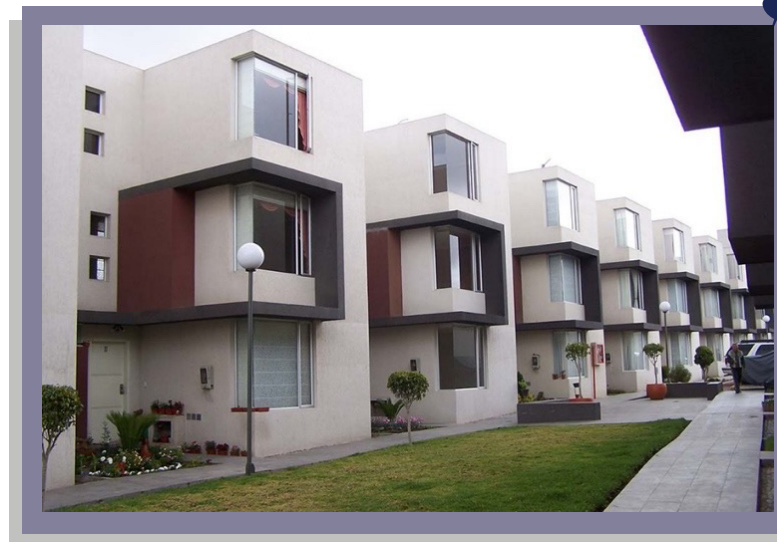
Imagen 29 Fotografía del proyecto vivienda social en Carapungo.
