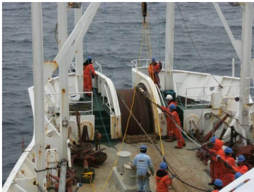
Figura 5. Operaciones de reparación de un cable submarino
