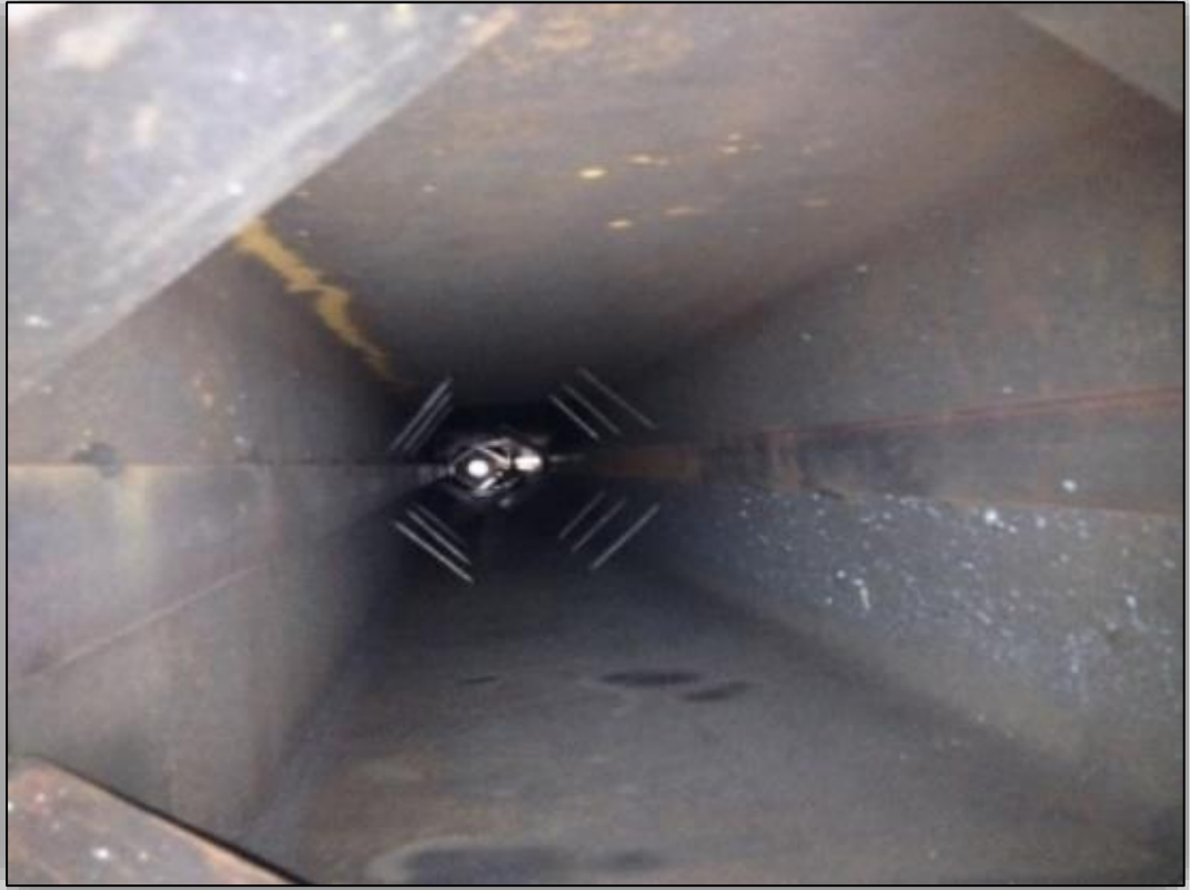
Ilustración 31: Fabricación de columnas sin conectores de corte
