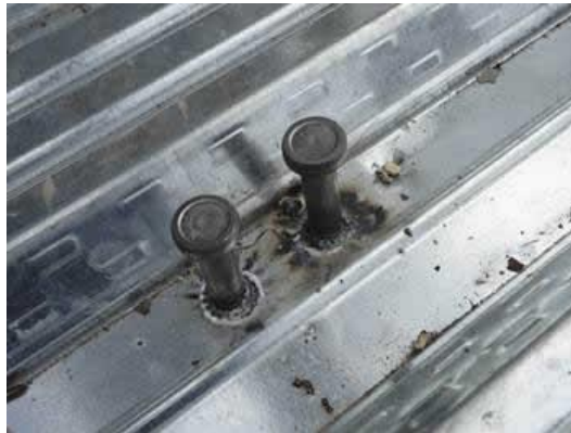
Ilustración 1: Conectores de corte para losa
