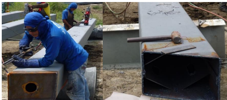
Ilustración 43: Remover tapa superior
