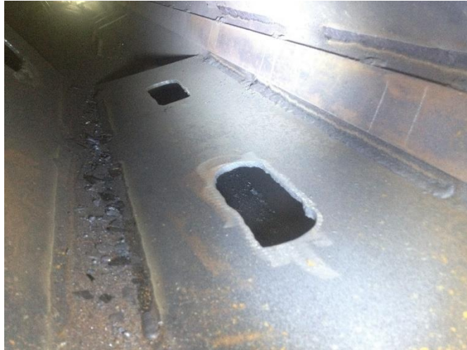
Ilustración 42: Soldadura completa de atiesadores
