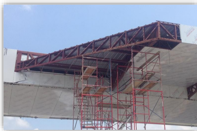
Ilustración 28: Foto de Estructura en obra. Con diagonales invertidas.
