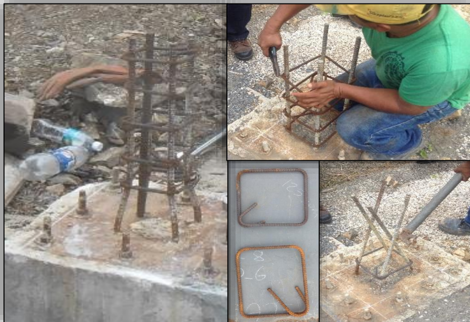
Ilustración 69: Detalle en obra
