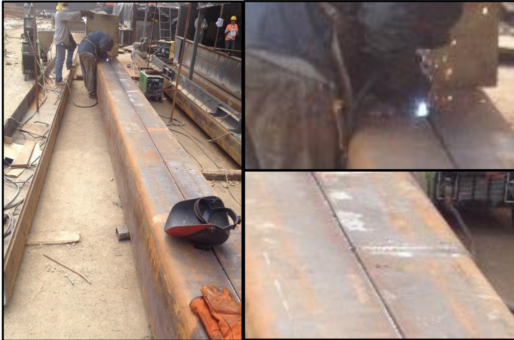
Ilustración 47: Ejemplo de empalmes para columnas.
