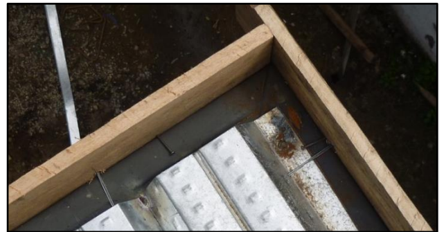
Ilustración 59: Distancia del encofrado al Steel panel
