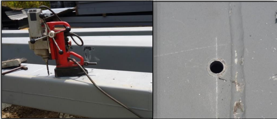
Ilustración 33: Perforación de cara de columnas con taladro magnético
