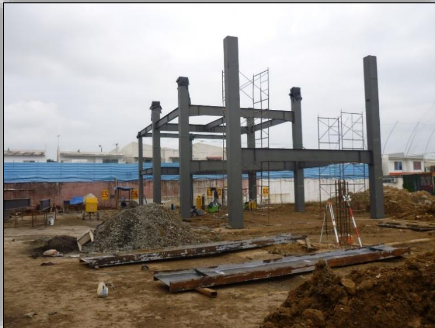
Ilustración 46: Columnas de 9m
