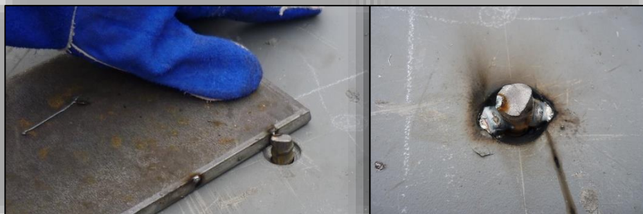
Ilustración 36: Soldadura de varilla de 12mm
