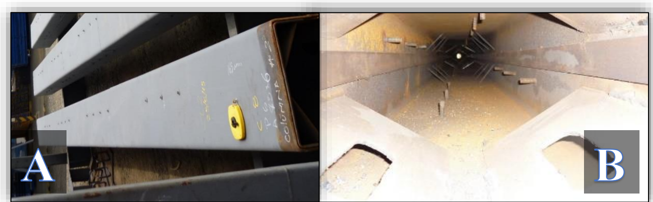
Ilustración 38: Conectores de corte con varilla de 12mm. A) Vista externa de los conectores agregados B) Vista interna de los conectores agregados
