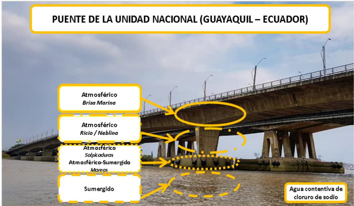
**Figura 1.3** Medios contentivos de cloruros en que puede estar expuesta una estructura de hormigón.
