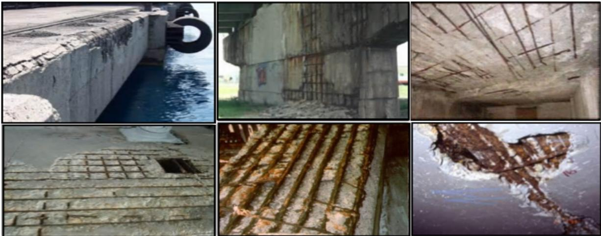
**Figura 1.4** Daños en estructuras de hormigón
