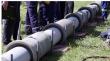
Figura 4.29: Procesos correspondiente al método correctivo de CIPP con curado UV.
