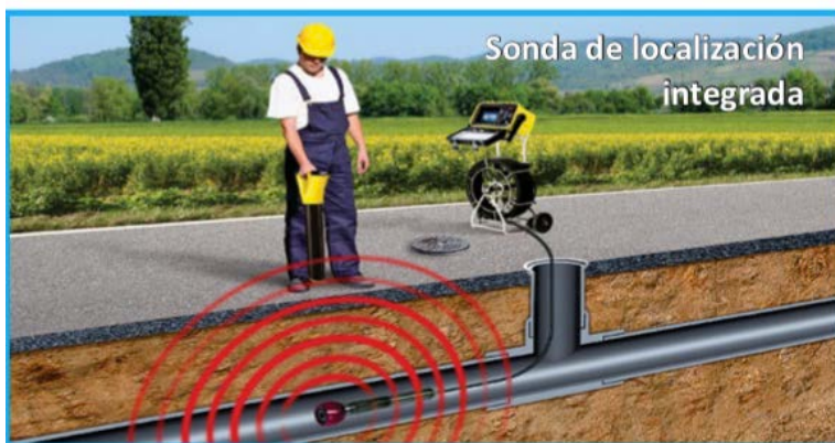
Figura 2.4: Inspección con CCTV con sistema de empuje manual
