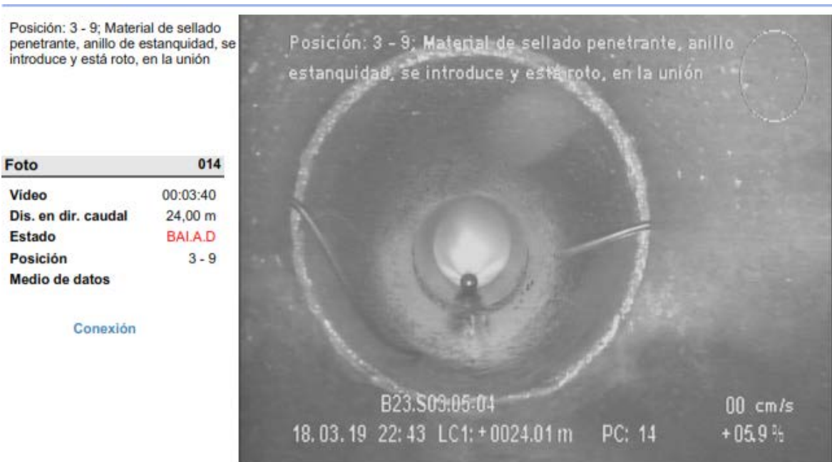
Figura 4.19: Registro fotográfico de material de sellado penetrante en el tramo inspeccionado.
