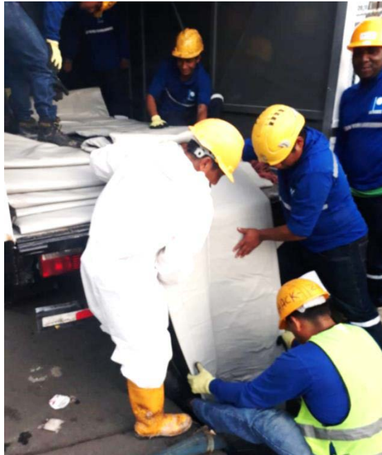
Figura 4.28: Introducción de la manga mediante el pozo de inspección.
