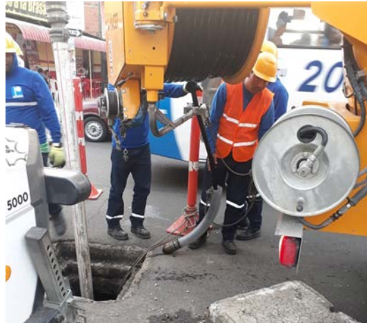
Figura 4.25: Introducción del hidrojet en el colector mediante el pozo de inspección.
