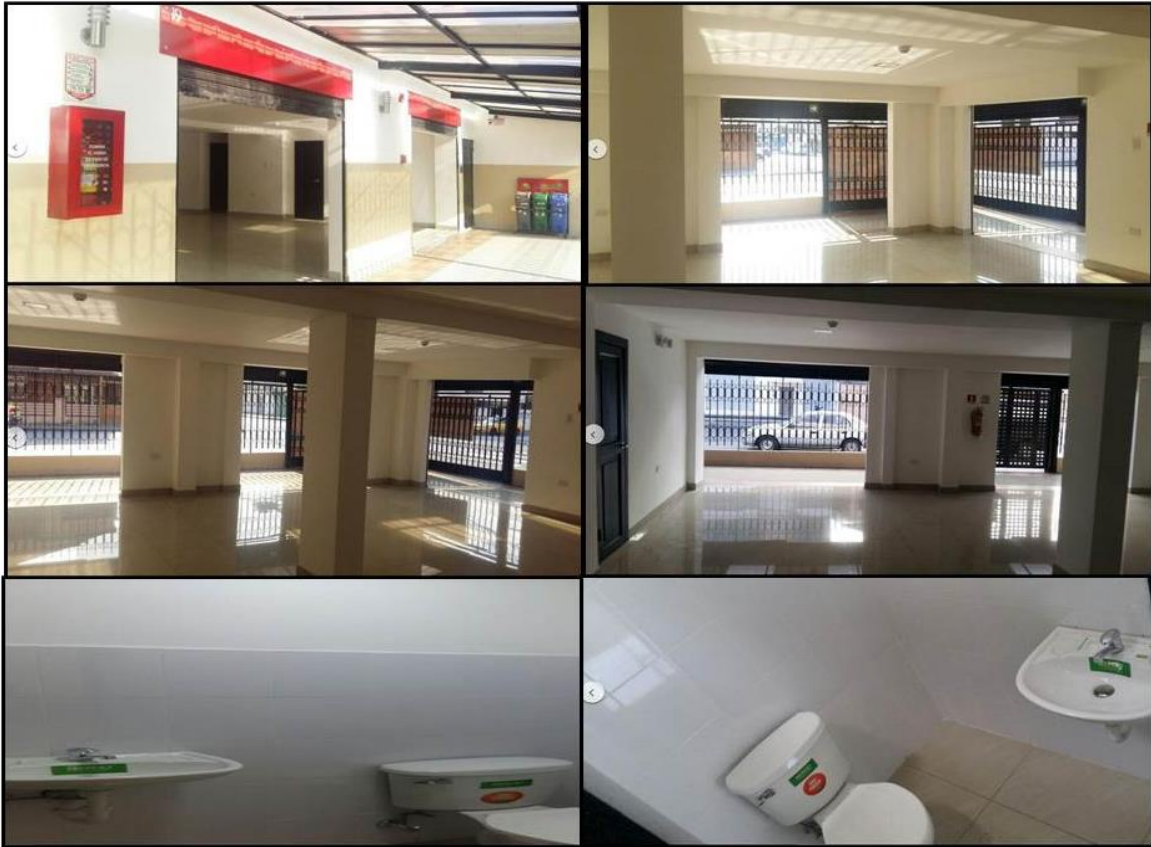
Figura 19. Instalaciones del local Fuente: Autor
