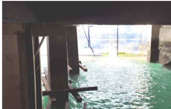
Fotografía 1-19 Atraque de embarcaciones en pilotes reparados
