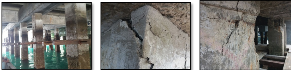
Fotografía 1-10 Pilotes fisurado
