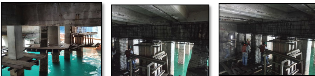
Fotografía 1-15. Encamisado de pilotes
