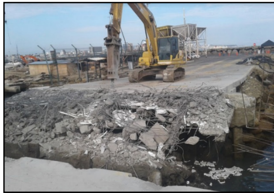
Fotografía 1 – 17. Demolición del acceso
