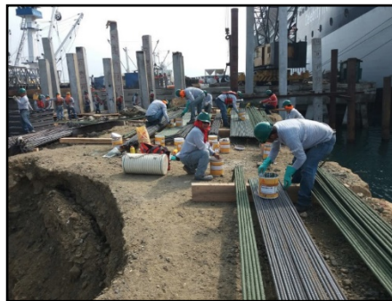
Fotografía 1-14 Protección del acero de refuerzo
