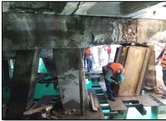
Fotografía 1-16. Encofrado de pilote
