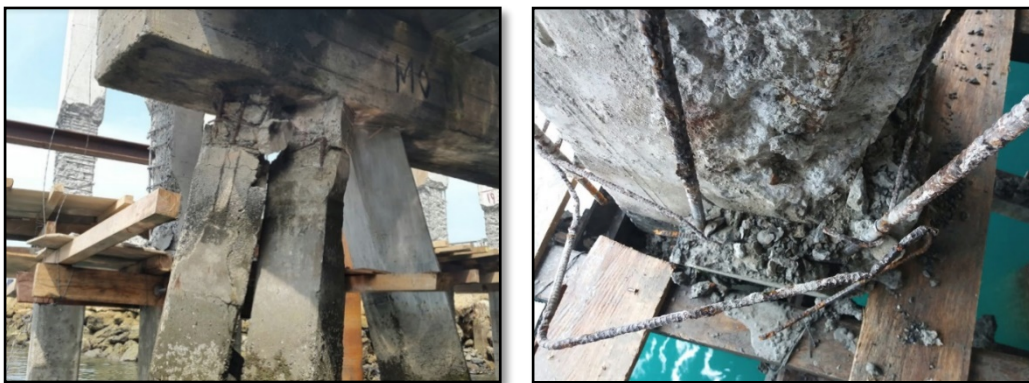
Fotografía 1-13 Efecto de columna corta
