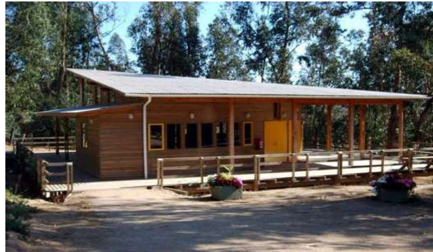
Imagen N.23- Sala multiuso Fuente: (Sielfeld & Sielfeld, 2017)
