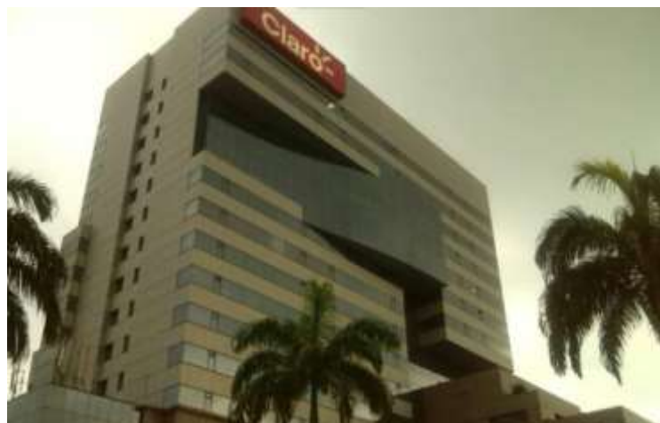
Figura 7 Edificio compañía CLARO
